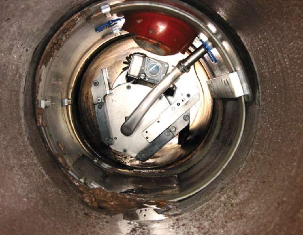
Detailansicht während der Sanierung
